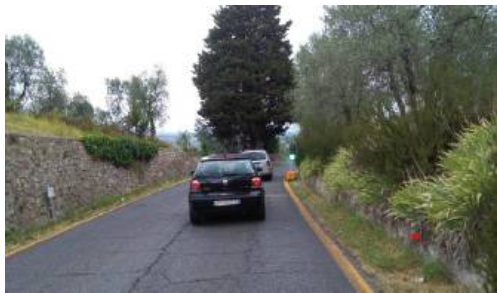
DISAGI Lavori sull'Imprunetana per Pozzolatico
